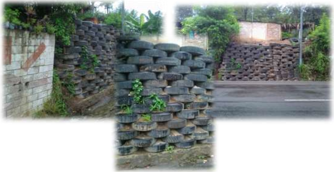
Imagen 2.04 Muro de Contención hecho de llantas enteras, ubicado sobre la Carretera que de Santa Ana conduce hacia San Salvador.
