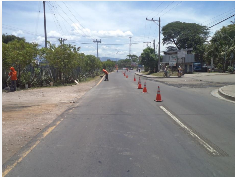
FIG. 5 5 LIMPIEZA DE SUPERFICIE PREVIO A APLICACIÓN
