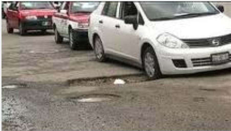
FIG. 5 12 BACHES EN VÍAS PRINCIPALES
