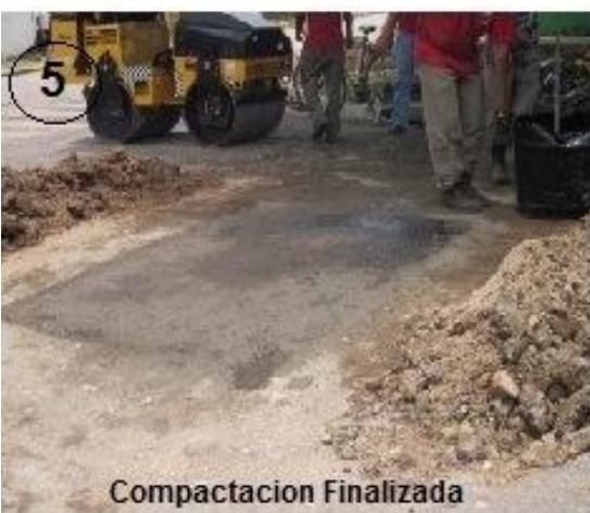
Figura N° 4.6 Secuencia de la Colocación y Compactación del CCR en Campo. Fuente: Grupo de Tesis.
