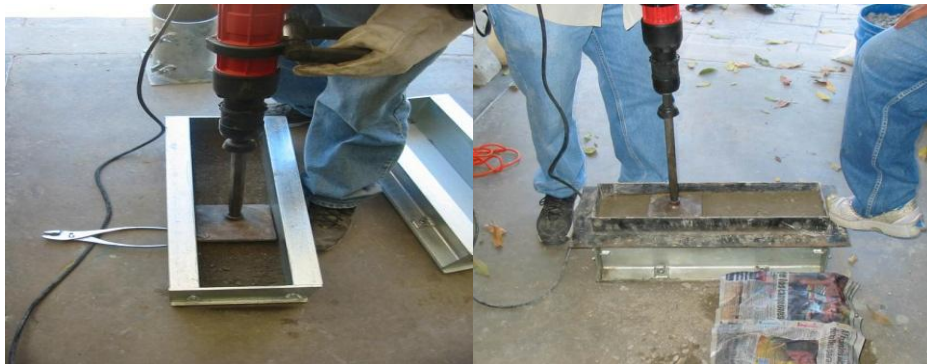
Figura N° 3.8 Compactación de viguetas y colocación de collarín para compactación de la última capa. Fuente: Grupo de Tesis.
