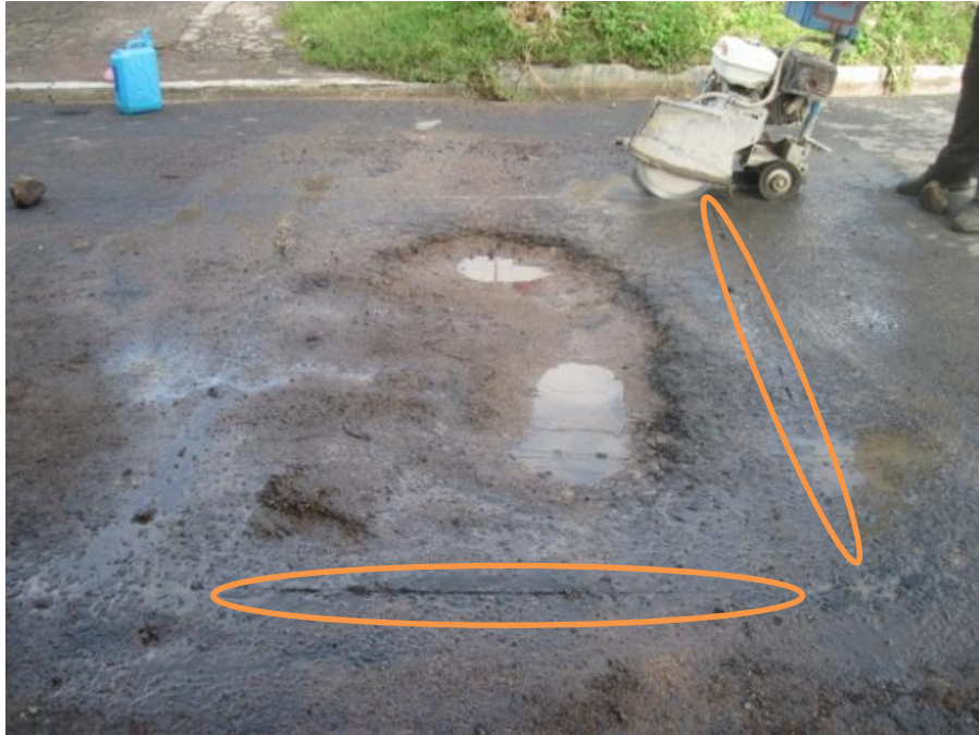
Figura N° 4.3 Corte del pavimento. Fuente: Grupo de Tesis.
