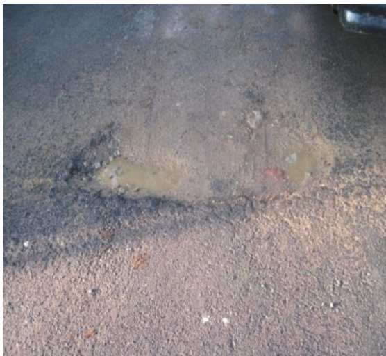
Figura N° 4.1 Selección del área de pavimento a reparar. Fuente: Grupo de Tesis.
