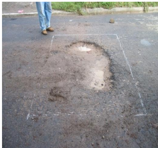
Figura N° 4.2 Delimitación y marcado del área de pavimento. Fuente: Grupo de Tesis.
