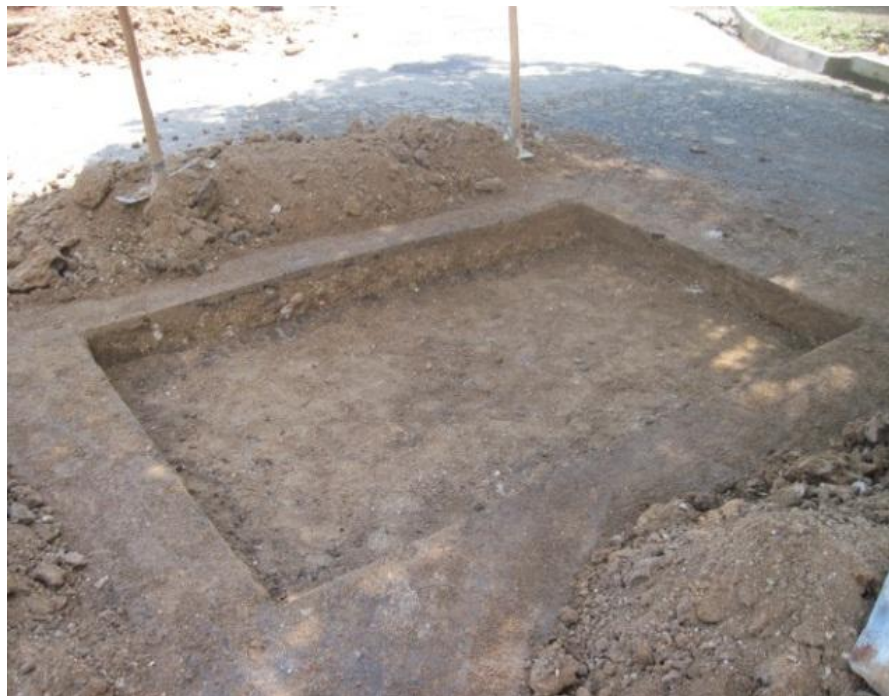
Figura N° 4.4 Excavación en la estructura del pavimento. Fuente: Grupo de Tesis.
