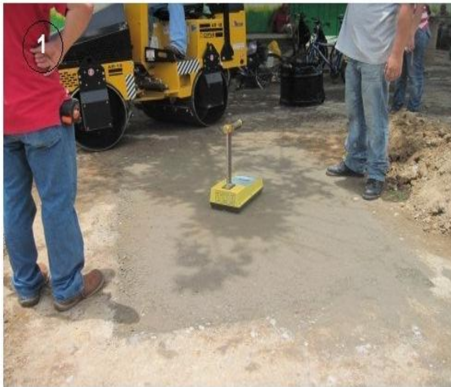
Figura 4.9 Colocación del densímetro nuclear para determinar la densidad de compactación alcanzada en campo. Fuente: Grupo de Tesis.
