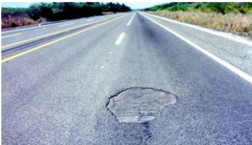
*Imagen 2.12. Pérdida de la capa de rodadura (peladura)*
