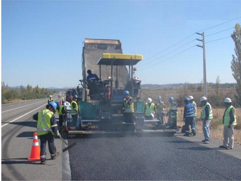
*Imagen 4.3. Extensión de micropavimento en caliente con maquina pavimentadora<sup>60</sup>*
