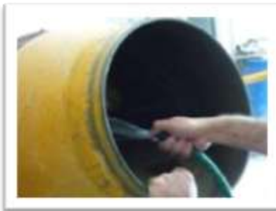
Fotografía 2.1.4 Preparación de concretera.
