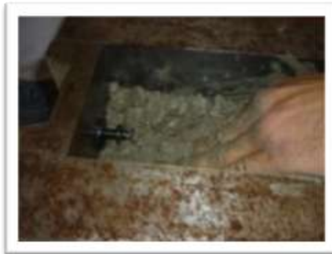
Fotografía 4.5 Acomodamiento manual de concreto en moldes.
