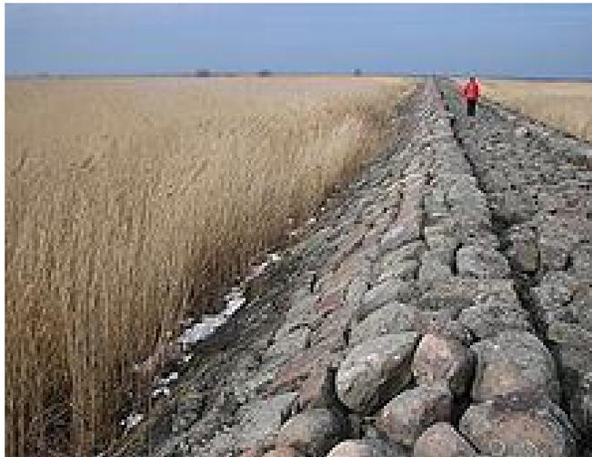
Figura 2.20. Dique longitudinal de piedra para control de inundaciones. Fuente. Pg web: <http://es.wikipedia.org/wiki>
