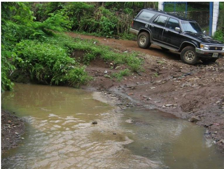
*Figura 1.4. Muestra el flujo del agua sobre el camino rural que comunica el Cantón El Jobo y el Caserío Los Escalantes. Fotografía tomada el 8 de septiembre de 2010. Fuente. Elaboración propia.*
