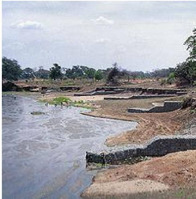
Figura 2.23. Espigones contruidos con gaviones, para proteger las márgenes de un río.
