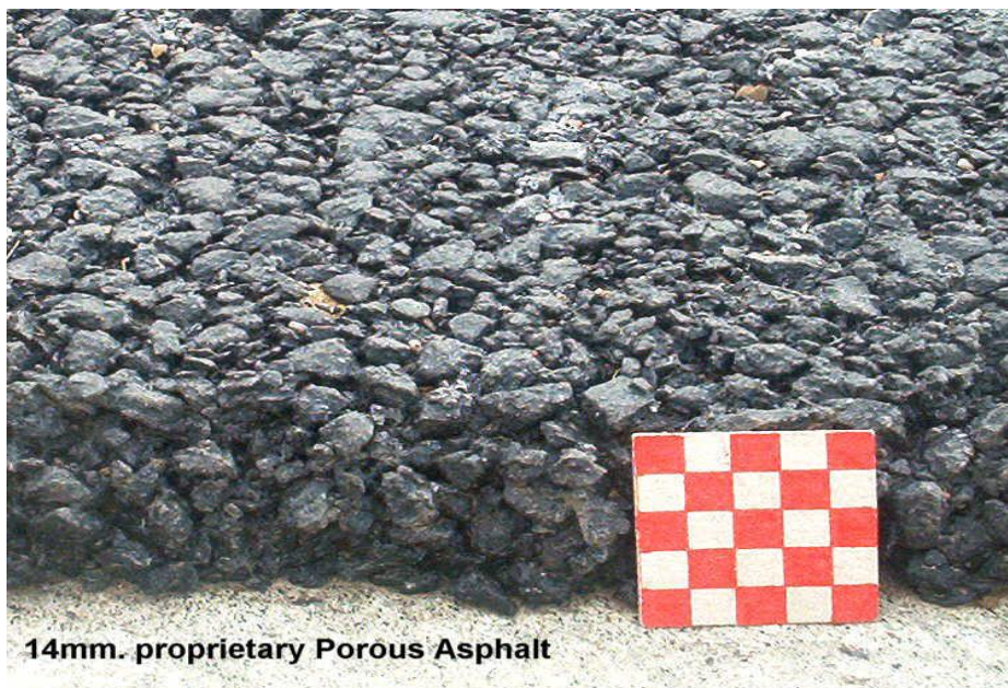
Fotografía 1.2 Carpeta de concreto asfáltico de granulometría abierta en el tramo de carretera San Martín-San Rafael Los Cedros 3 .
