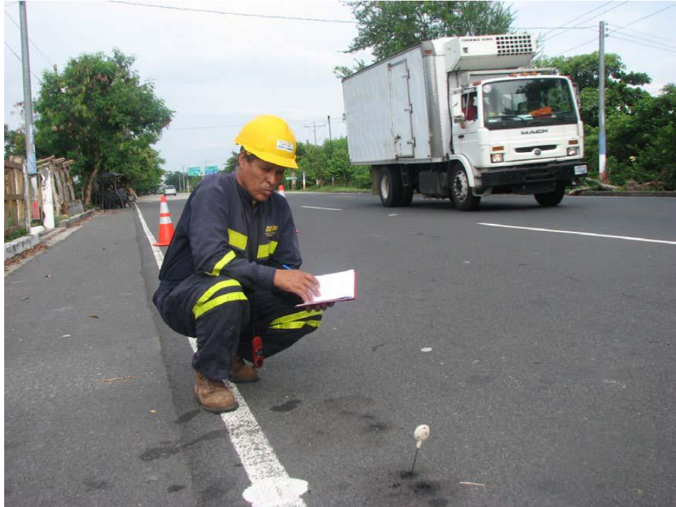
Fotografía 3.1. Medición en Carretera del Litoral, Desvío Zacatecoluca-Comalapa. Personal de la UIDV, durante la toma de registro de temperatura superficial del pavimento. 49
