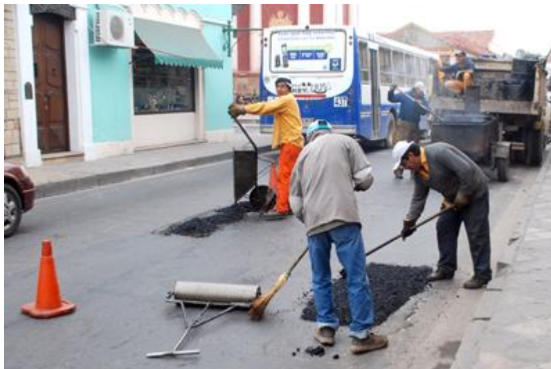
Fotografía 2.6. Mezcla en sitio 23 .
