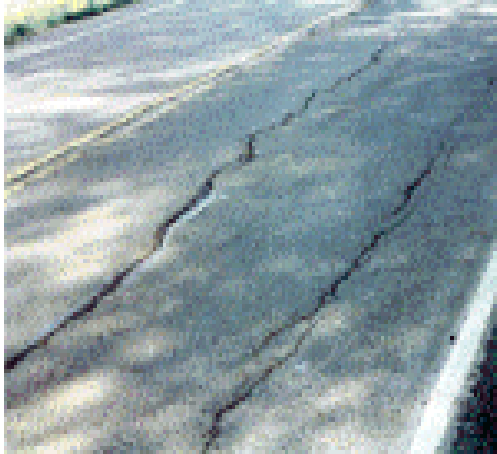
Fotografías 2.12. Agrietamientos y Fisuras en pavimentos asfálticos 29 .
