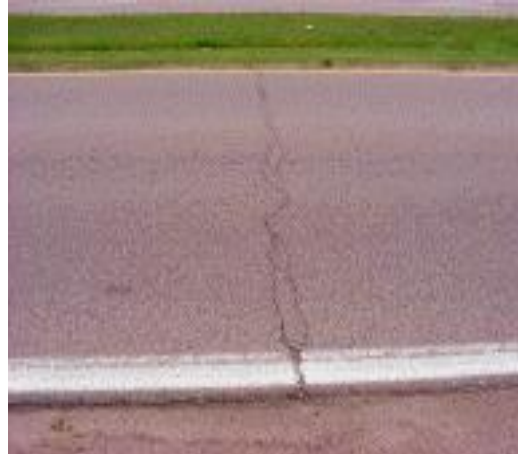
Fotografías 2.12. Agrietamientos y Fisuras en pavimentos asfálticos 29 .
