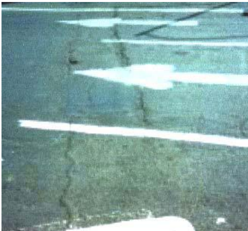
Fotografías 2.7. Fallos en la Construcción de pavimentos asfálticos 24 .
