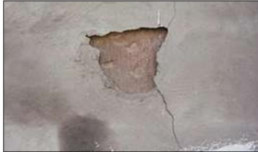
ILUSTRACIÓN 8: DESPRENDIMIENTO EN REPELLO.
