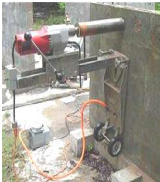
ILUSTRACIÓN 28: EQUIPO PARA PERFORAR LAS PAREDES DE ENSAYO.
