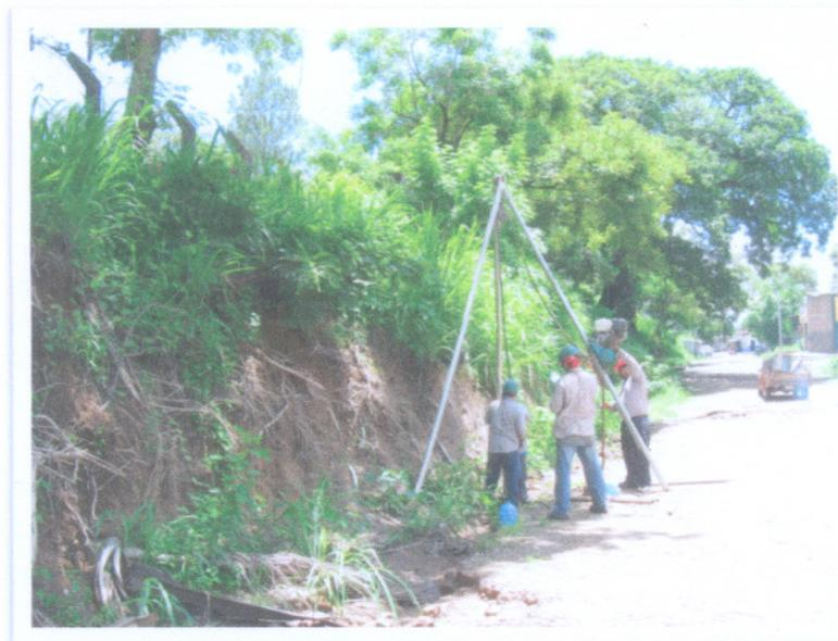
*Fotografía N°4: Ejecución del sondeo S-5 en proceso de ejecución.*
