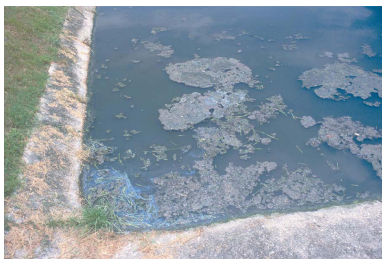
Fig. 6.3 Las natas y los sólidos flotantes usualmente se acumulan en las esquinas de las lagunas, principalmente llevados por el viento
