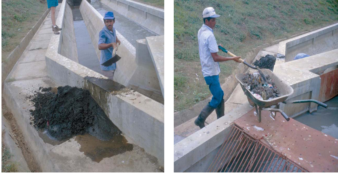
Fig. 6.2 La responsabilidad del operador es limpiar la rejilla diariamente y el desarenador cuando sea necesario, típicamente una vez por semana
