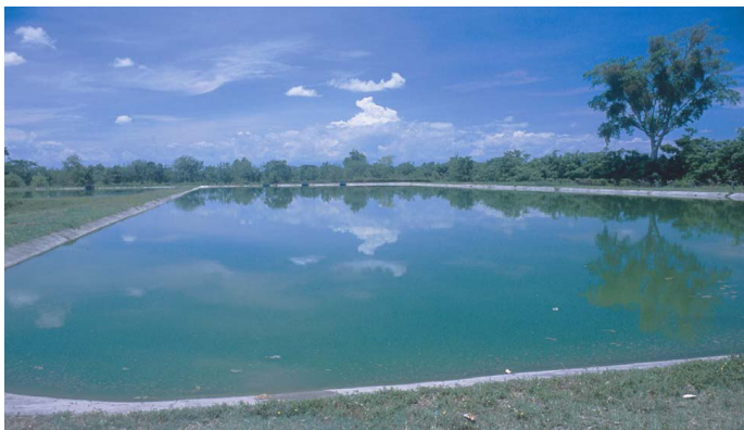
Fig. 4.3 Laguna Facultativa en buen funcionamiento.
