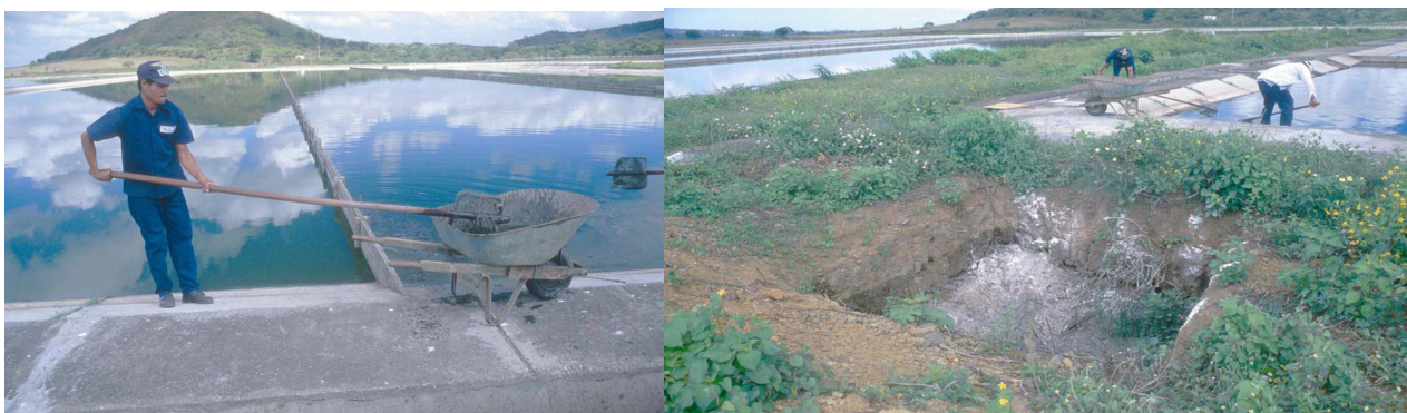
Fig. 6.4 Las natas y desechos deben enterrarse y cubrirse con una capa de suelo o cal para controlar los olores.
