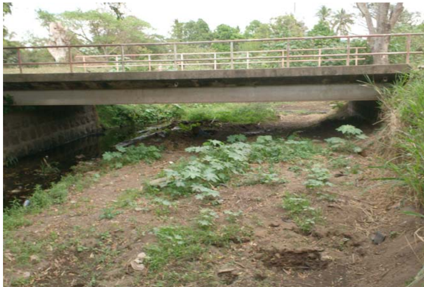
Foto 1.2. Puente de acceso principal al municipio El Porvenir.
