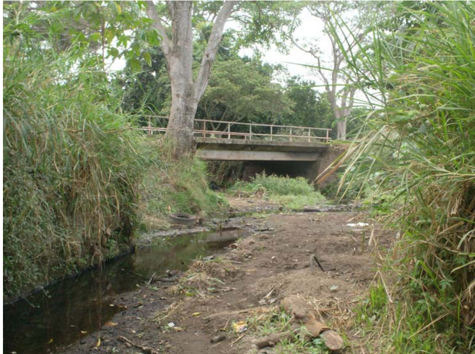
Foto 5. Obra de paso existente en el Río El Porvenir y principal vía de acceso al municipio El Porvenir.
