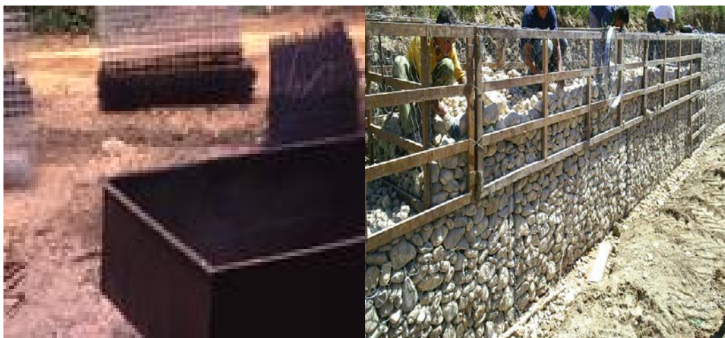
Figura 4.9. Moldes para armar la estructura del Gavión.
