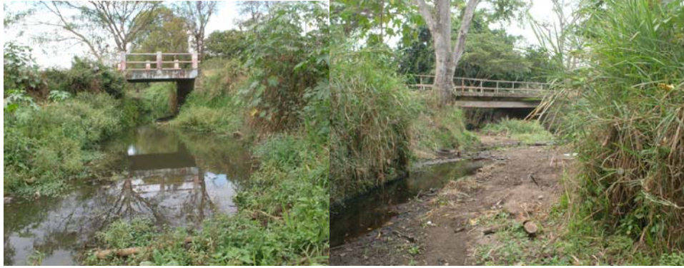
Foto 1.6. Obras de paso existentes.
