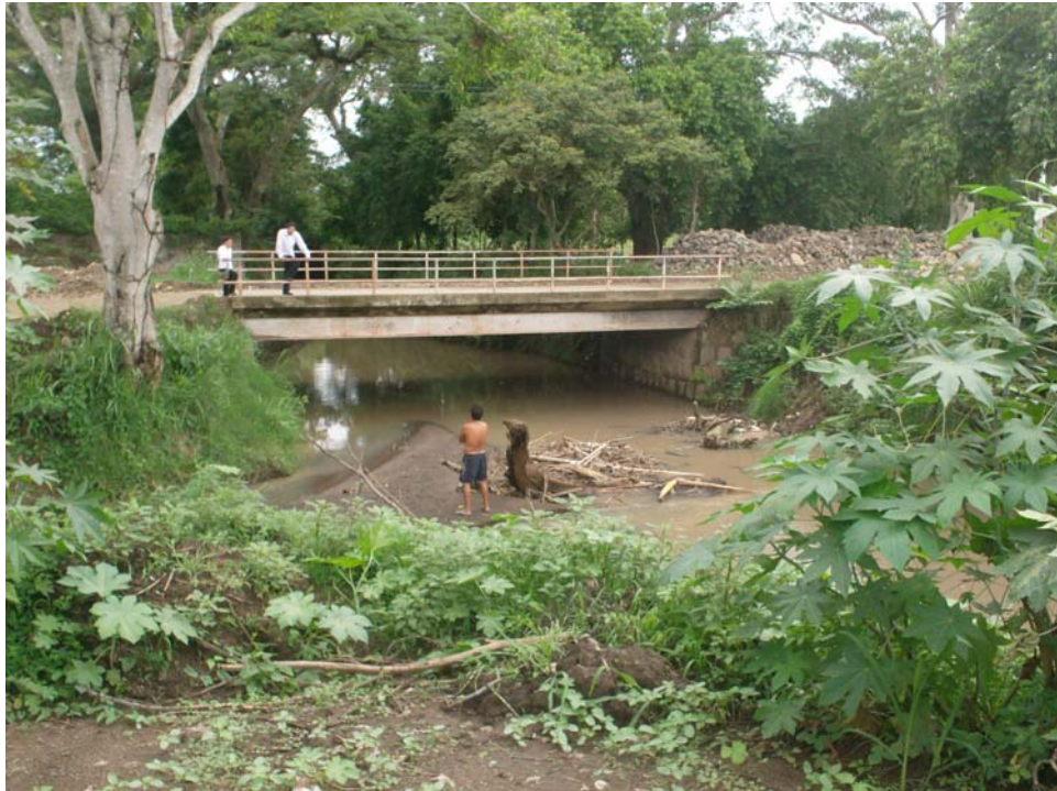
Foto 7. Vista panorámica de la condición del Río El Porvenir al inicio de la época lluviosa.
