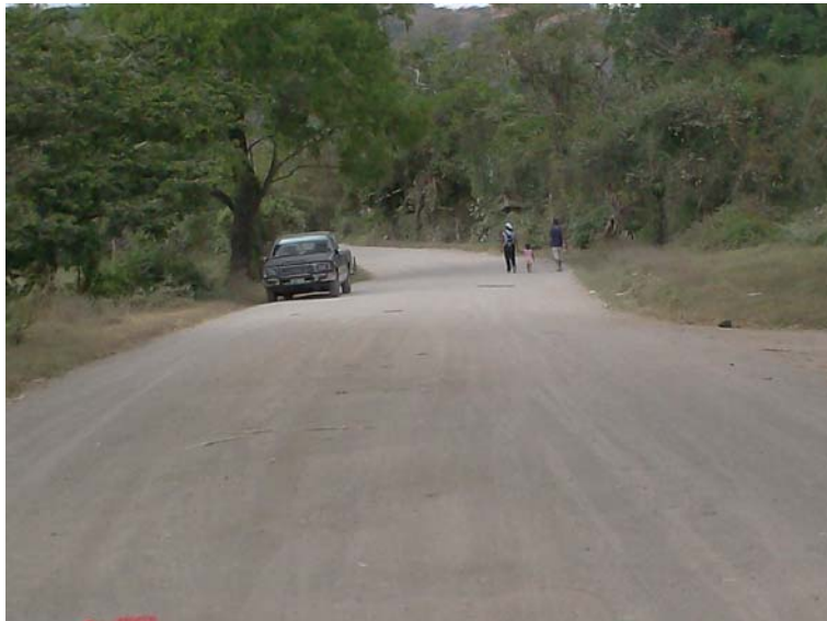
Foto 1.1 Vía de acceso al Municipio de El Porvenir.
