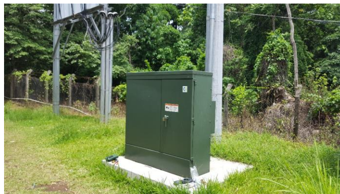
Figura 10. Foto de transformador pedestal trifásico No. 1 de la FMOcc25
