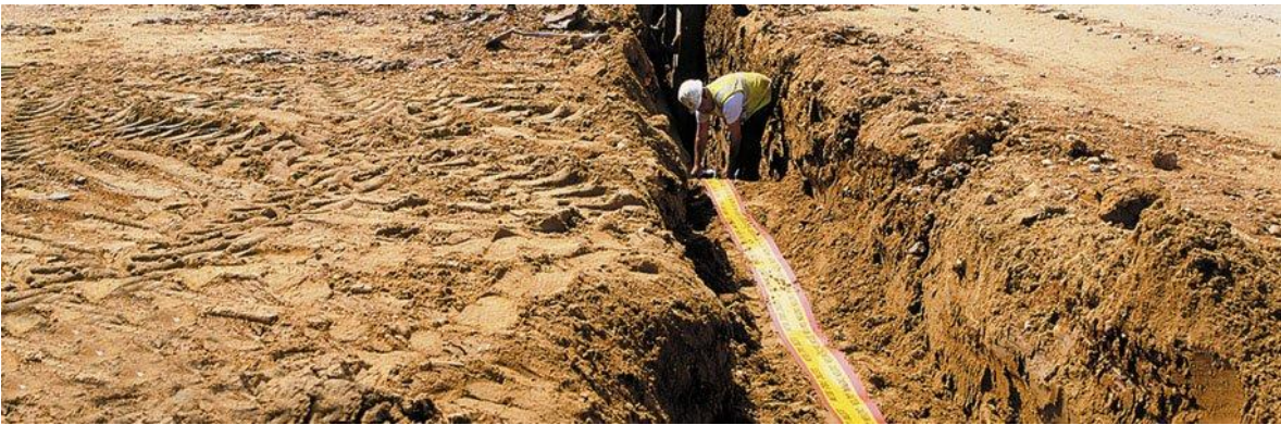
Figura 121. Cinta de precaución siendo colocada en trincheras.
