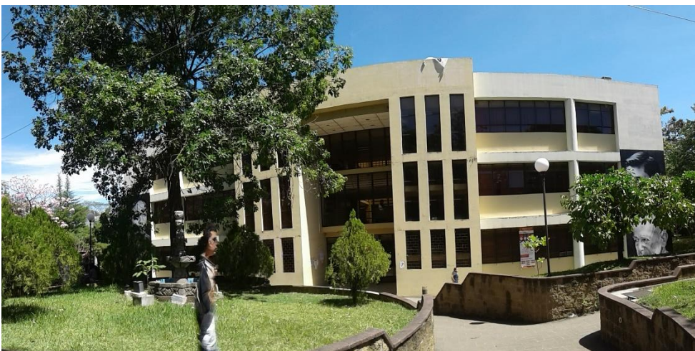
Figura 275. Edificio de usos múltiples, parte frontal del edificio.
