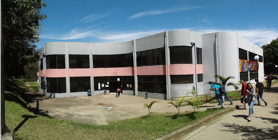
Figura 274. Edificio de medicina, entrada principal.
