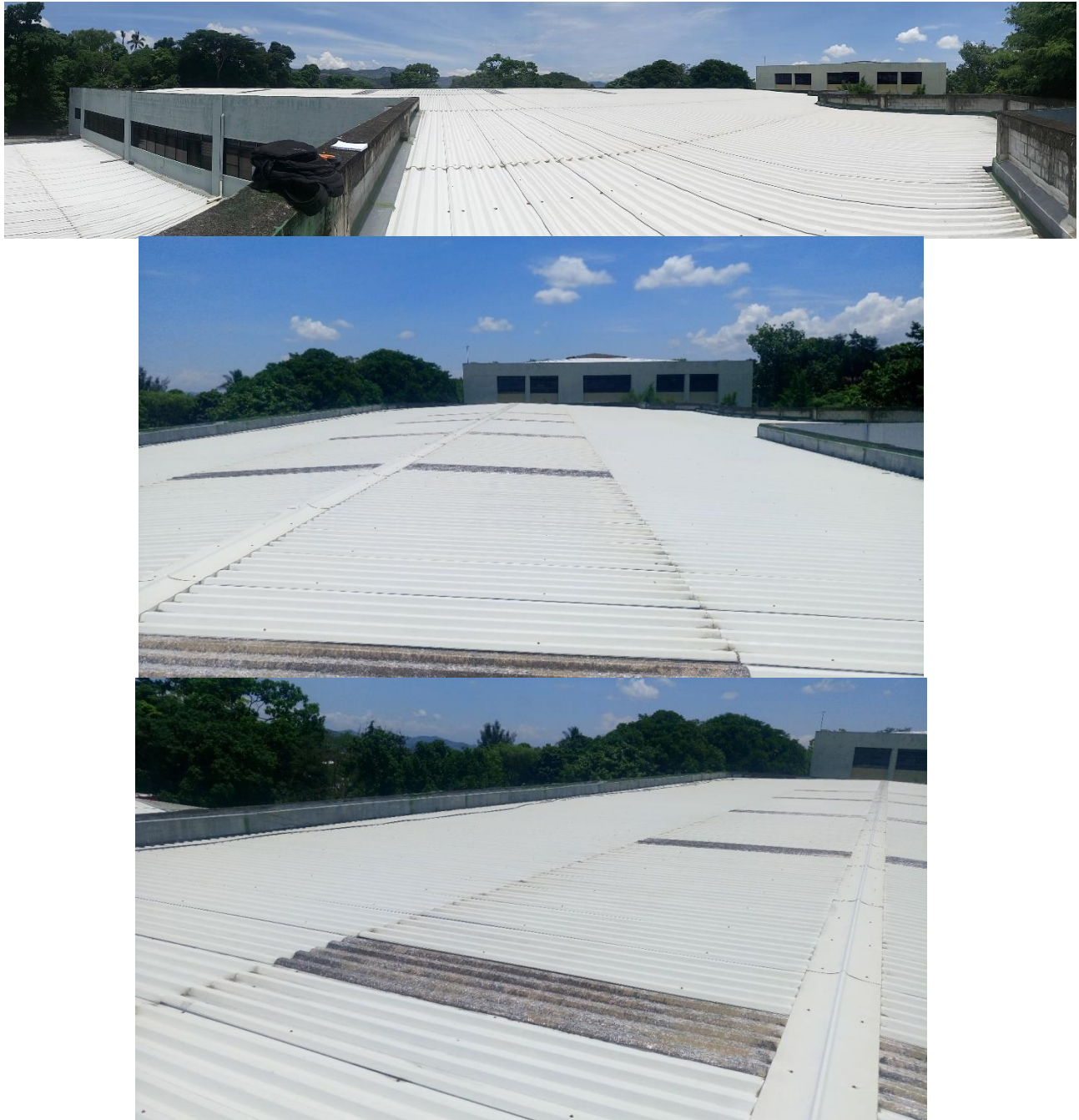
Figura 243. Fotografías del techo de "Edificio de medicina".
