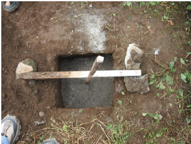
ANEXO 10b. Vista de pozo terminado de 30 x 30 x 40 cms con capa de arena gruesa en el fondo y perdiga de medición.
