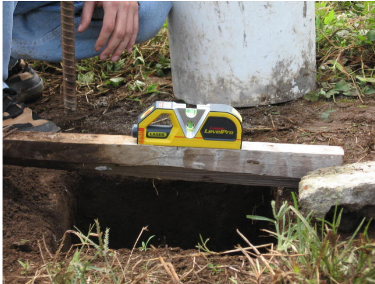
ANEXO 10a. Nivelación de superficie mientras se realiza la excavación de pozo a cielo abierto.
