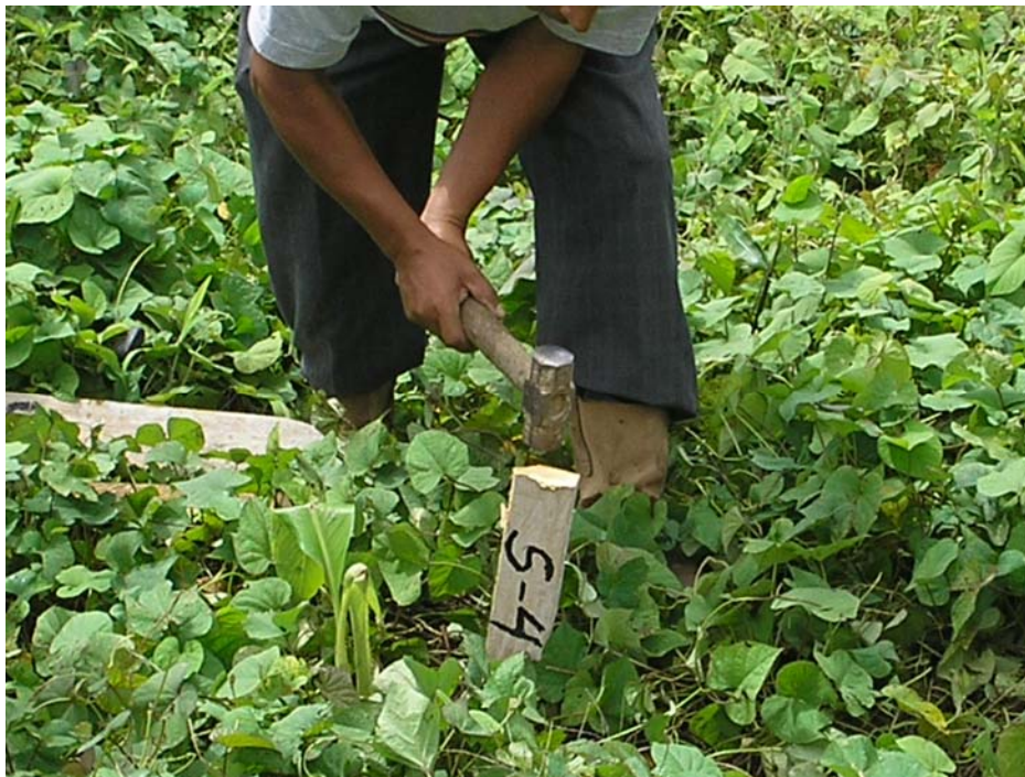
Anexo 8b. Colocación de Estaca en el lugar respectivo
