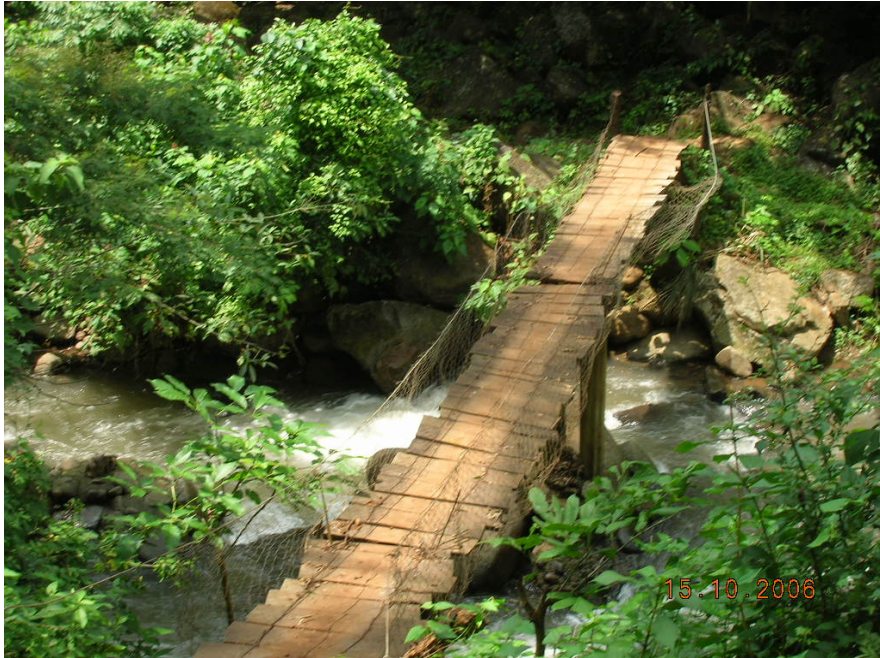
Fotografía 4.i. Est. 13+700.00, Calle Los Castillos, Caserío San Antonio Arriba, Cantón San Antonio.
