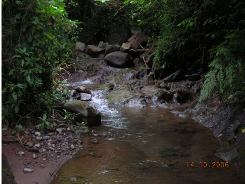
Fotografía 4.a. Ubicación de la Obra de Captación Superficial Est. 0+000 en el río San Antonio (Vista Aguas Arriba).
