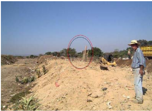
Relleno Ctón. El Zunca. Drenaje de gases
