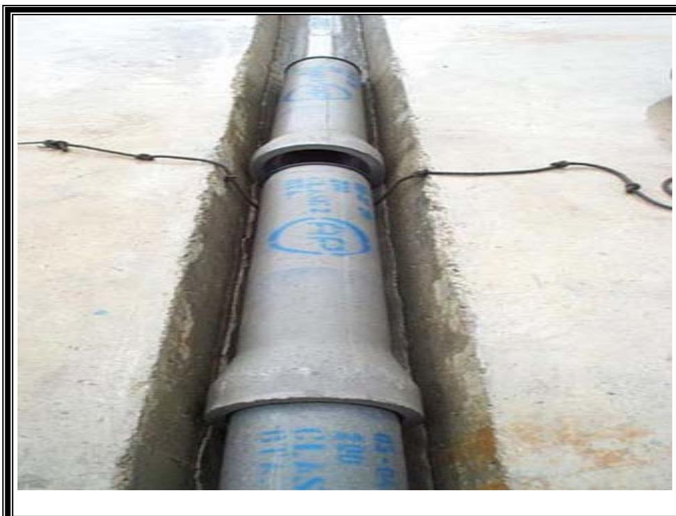
**Imagen II – 3 Instalación de tubería Concreto**
