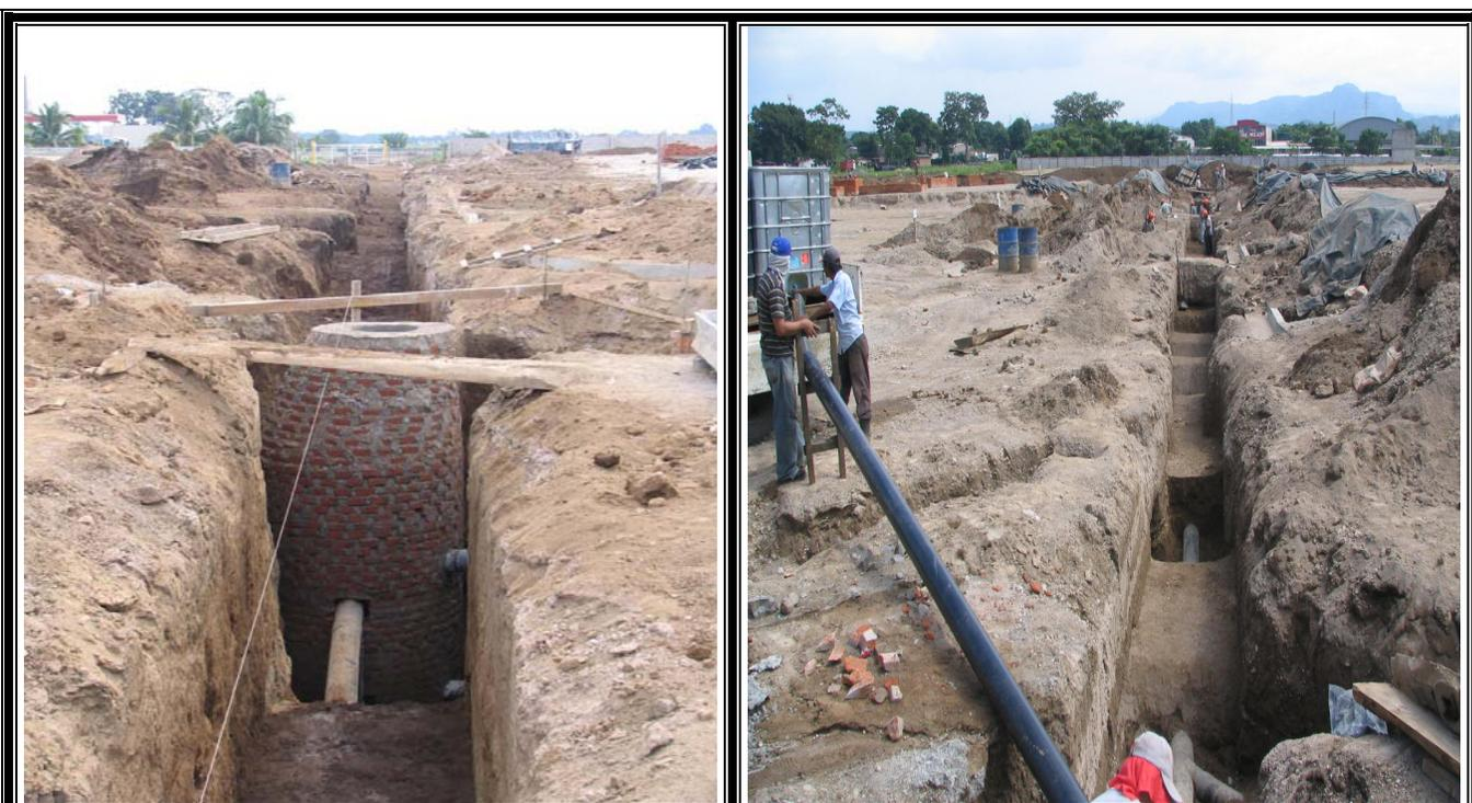
**Imagen II – 1 Instalación de tubería PVC**
