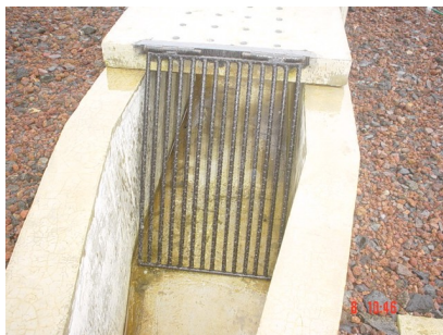
Figura 3.2 Fotografía de un sistema de rejjas simple y esquema del sistema de rejillas inclinadas para un pre-tratamiento.
