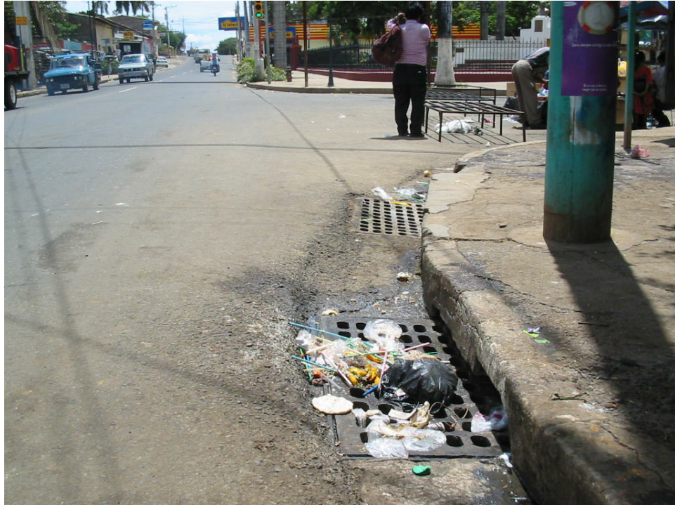
Fotografía 3: Obstrucción de caja tragante frente a Mercado Compañía Ahuachapán S.A.
