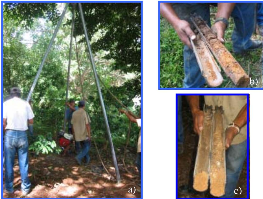
**Figura 3.10:** Extracción de muestras de suelo mediante penetración estándar.
