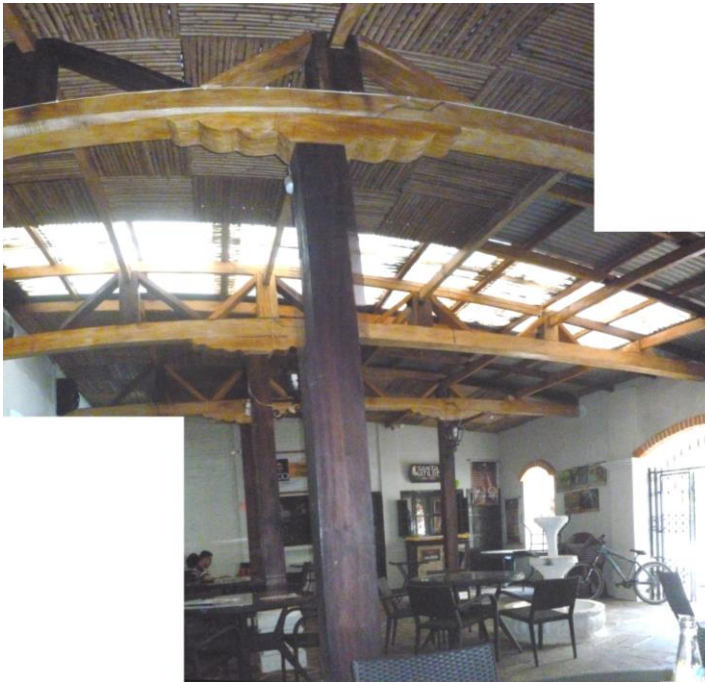
Ilustración 46 detalle distribución estructural
