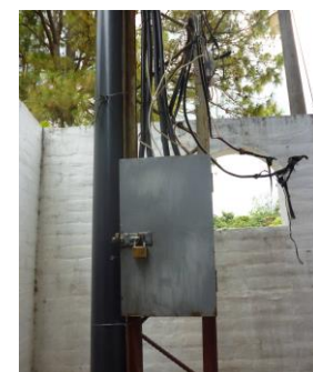
Ilustración 71 caja termica
