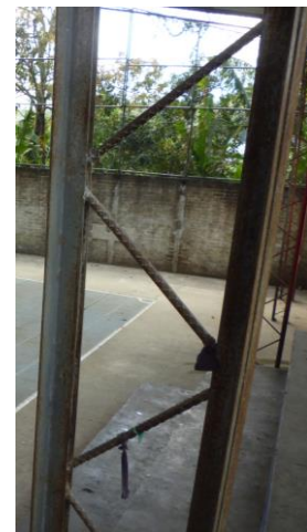
Ilustración 66 detalle de columna estructural de techo
