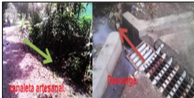
Fotografía 2.5 Canaleta Artesanal y Canaleta Transversal. Fuente: Autoría propia de grupo de trabajo de grado.
