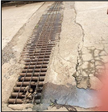
Fotografía 2.3 Canaleta Transversal. Fuente: Autoría propia de grupo de trabajo de grado.
