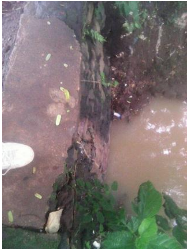
Fotografía 3.4 Quebrada sobre calle poniente del área urbana del municipio de Turín con muros de mampostería de piedra existente. (Descarga 1). Fuente: Autoría propia de grupo de trabajo de grado.
