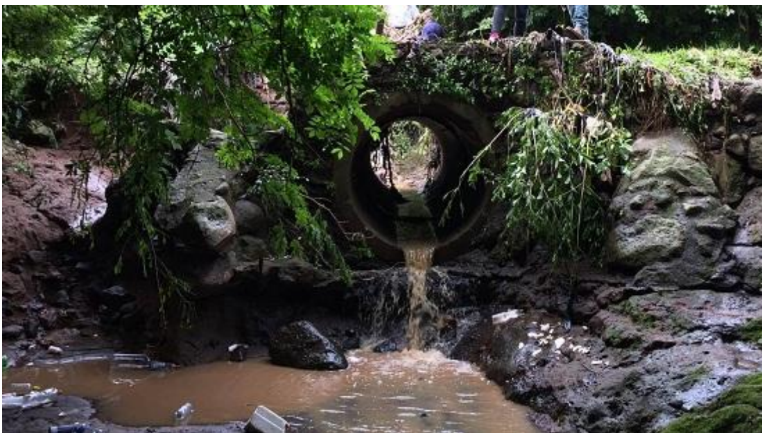
Fotografía 3.2 Quebrada al Noroeste de escuela El Carmen con muros de mampostería de piedra existente. (Descarga 3). Fuente: Autoría propia de grupo de trabajo de grado.
