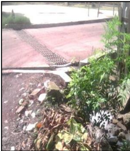
Fotografía 2.4 Canaleta Transversal. Fuente: Autoría propia de grupo de trabajo de grado.
