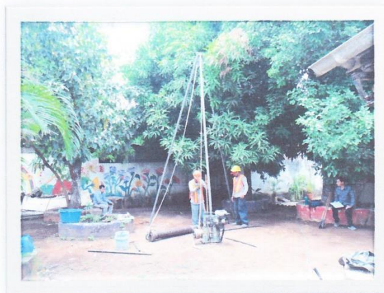
FOTOGRAFÍAS DE LOS ENSAYOS S.P.T. EN EL TERRENO.
