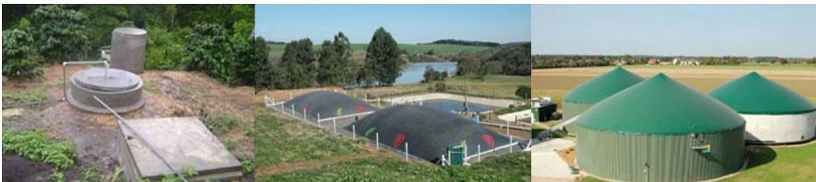
Imagen 3. S.F. Modelos de biodigestores. De izquierda a derecha se tiene el modelo chino, modelo manga de geo membrana y una planta de biometano
