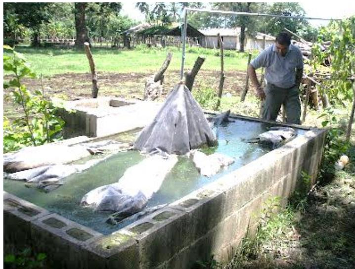
Biodigestor colapsado debido al inadecuado diseño que se llevó a cabo, el plástico cobertor no soportó la presión del biogás.
