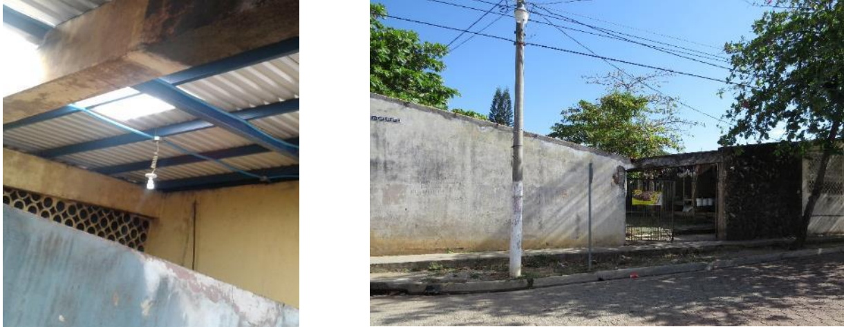
Figura 52 alumbrado eléctrico interno y público
