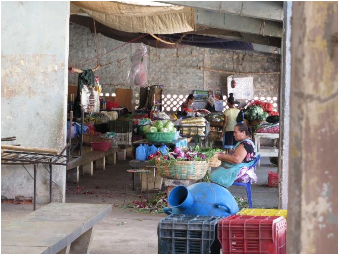
Figura 46 estado actual interior Mercado Municipal
