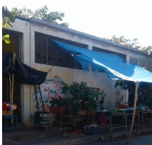
Figura 48 acceso principal Mercado Municipal
