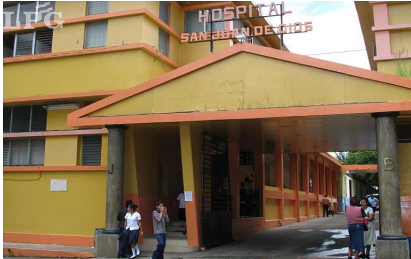
Ilustración 1 Vista de la fachada del Hospital Nacional San Juan de Dios de Santa Ana
