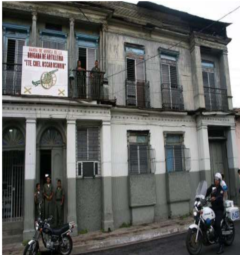
IMAGEN 2.3.5: fachada del inmueble 5ª brigada de Artillería Tte. Cnel. Oscar Osorio. FUENTE: Equipo investigador.
