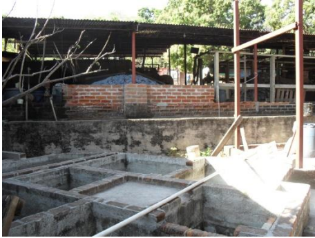
Imagen 5 Vista panorámica de las instalaciones de tenería DIPOL S.A. de C.V.
