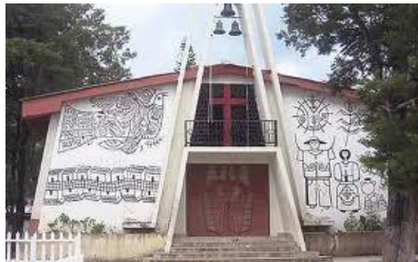
Imagen 76 Fachada principal de la "Iglesia Católica de La Palma" Fuente: Grupo de Investigación.
