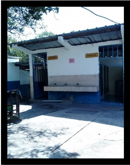
FOTOGRAFIA 5.1 Servicios sanitarios del Centro Escolar Reparto Guadalupe
