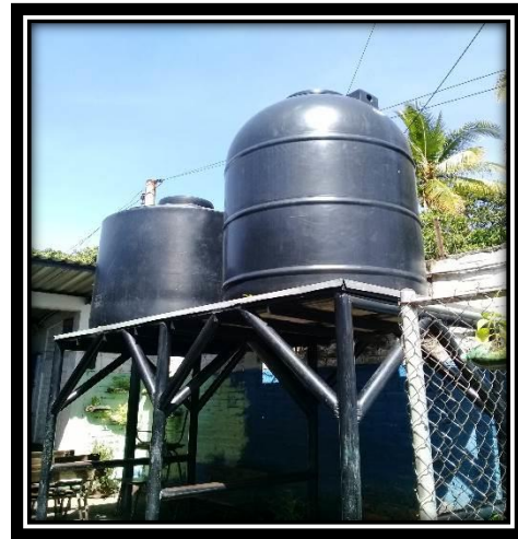
FOTOGRAFIA 3.2 Cisternas en buen estado
