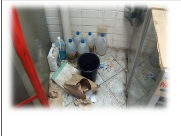
Acumulación de químicos en lugares no adecuados
