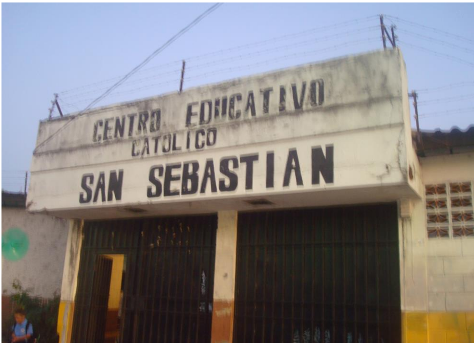
Entrada Principal del Centro Escolar Católico San Sebastian
