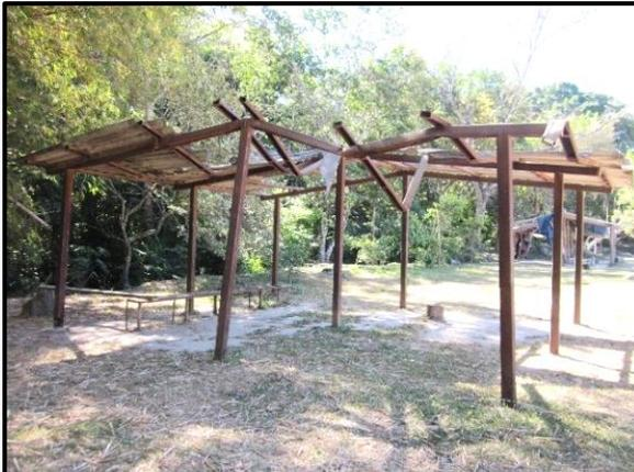
Foto 35: Estructura para sombra deteriorada.
