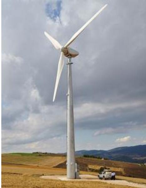
Figura 1.2 Turbina de Eje Horizontal de tres palas.
