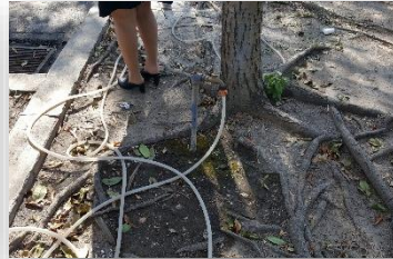
Imagen 41. Raíces superficiales de árbol de Barrillo obstruyendo tubería de PVC de agua Potable Recuperado: Unidad Médica de Especialidades Atlacatl.
