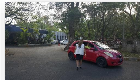
Imagen 46. Árboles de gran tamaño que ponen en riesgo la edificación Recuperado: Unidad Médica de Especialidades Atlacatl.
