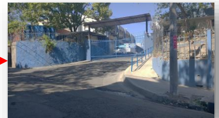
Imagen 38. Rampa de acceso de abastecimiento al 12.5%
