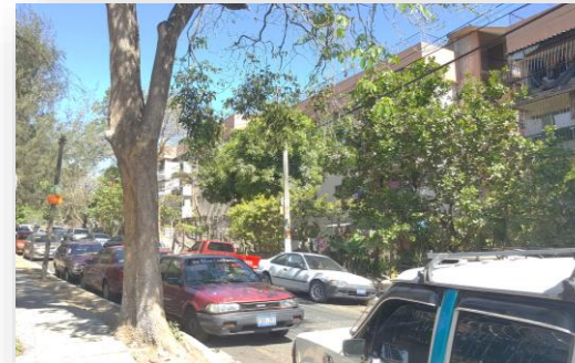
Imagen 51. Apartamentos Zona Oriente a la Unidad Recuperado: Pasaje Cipactly, San Salvador.
