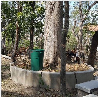
Imagen 42. Rompimiento de arriate por raíces de árbol de ceiba en área de Mesas Recuperado: Unidad Médica de Especialidades Atlacatl.
