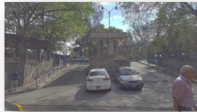
Imagen 32. Rampa de Acceso Principal al 15 %
