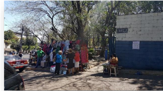
Imagen 63. Acceso únicamente peatonal, el cual no cuenta con diseño de rampas y está obstruida por ventas informales.
