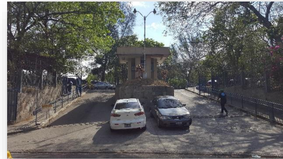
Imagen 64. Acceso peatonal y vehicular, posee rampas para personas con capacidades reducidas con porcentaje de pendiente del 15% en donde se debe usar una pendiente máxima de 7% adecuado para su uso 17 .
