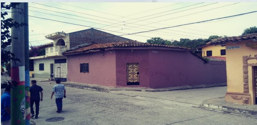
Fotografía N°15: Esquina Ochave, en la intersección Av. 5 de noviembre y 2ª Calle Oriente
