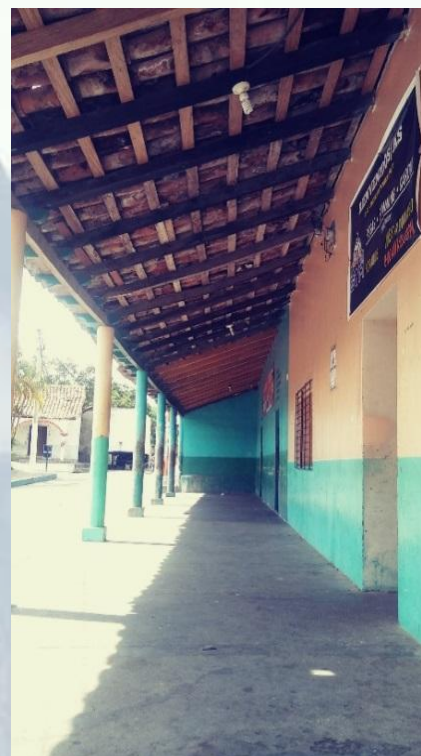
Fotografía N°12: Fachada con Portales, 2Av. 5 de Sur
