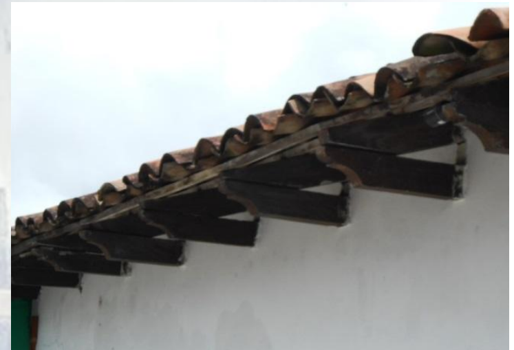
Fotografía N°14: Fachada con Alero
