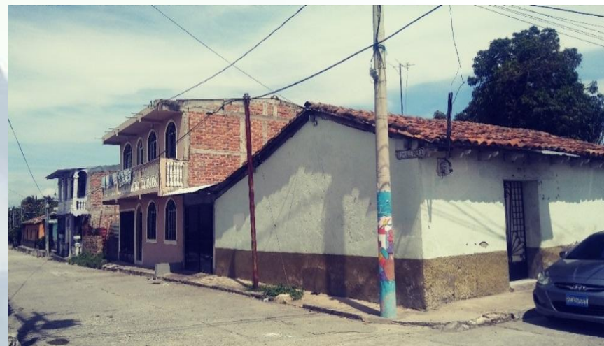
Fotografía N°16: Niveles de Edificaciones
