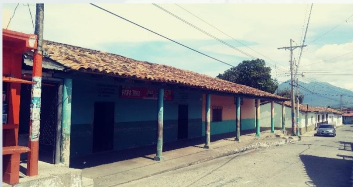
Fotografía N°9: Cubierta de Teja de Barro
