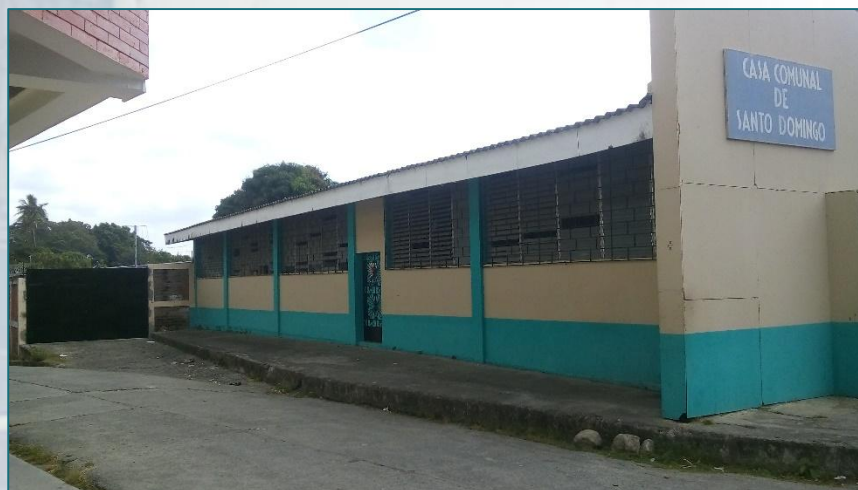
Fotografía N°5: Entrada sobre la calle 4 de junio
