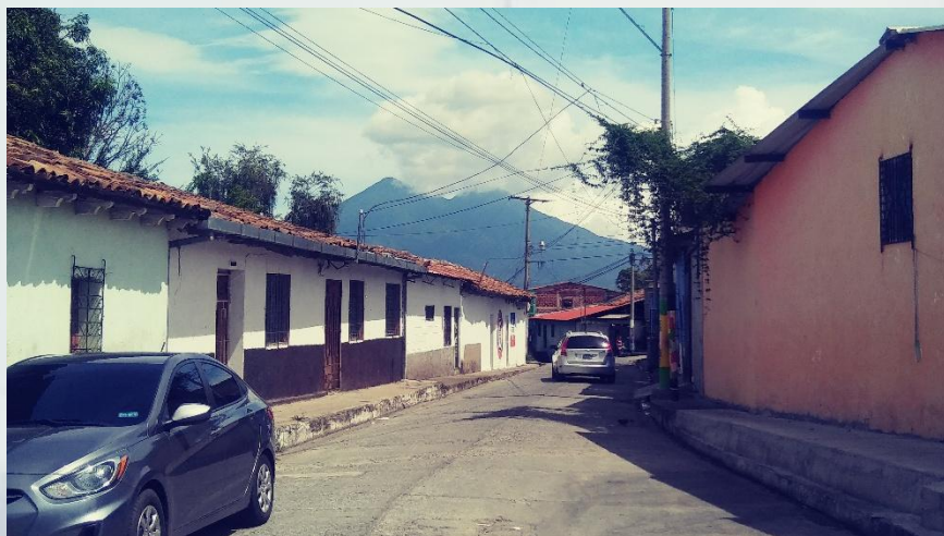
Fotografía N°11: Fachada Regular, Avenida 5 de noviembre
