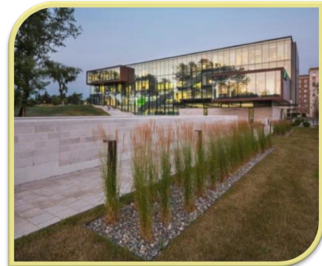
Imagen 54. Desjardins Group , perspectiva exterior. Fuente: Plataforma Arquitectura, 4 Noviembre, 2015
