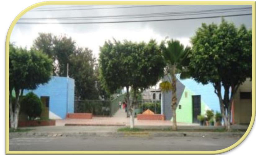
Imagen 17 . Acceso a complejo Katya Miranda sobre 23 Calle Pte. Fuente: Propia.
