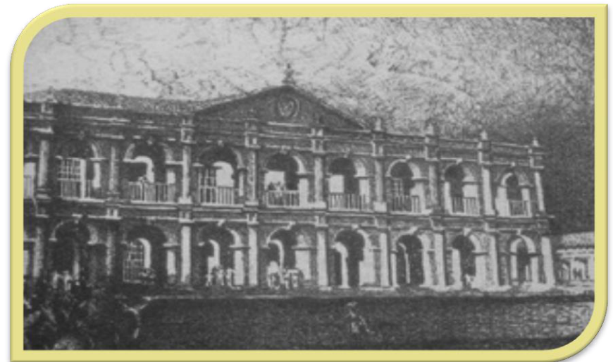
Imagen 1: Dibujo de antiguo edificio del Ayuntamiento de San Salvador en el año de 1789, derribado a causa de terremoto de 1854. Fuente: Periódico virtual Equilibrium.
