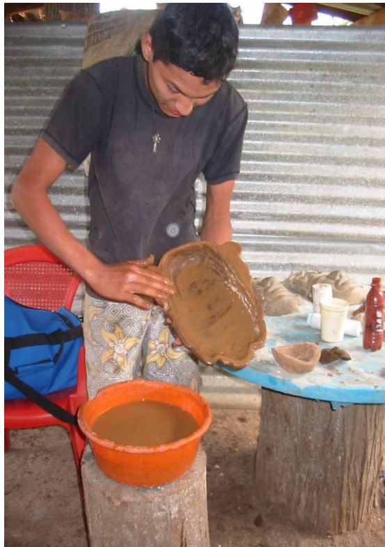
Figura No 12 Aplicación de barro líquido
