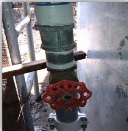
**Fotografía 10:** Válvula principal de paso, proveniente de la línea de conducción hacia el segundo tanque, donde se aplica el cloro a través de pastilla HTH de 250gr (Hipoclorito de calcio).
