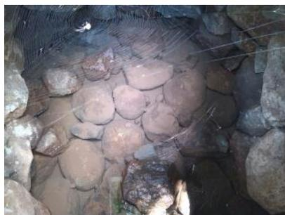
**Fotografías 1, 2 y 3:** Muestran como está estructurada la caja de inspección y su base que es un lecho de piedra en donde nace el agua para el abastecimiento.
