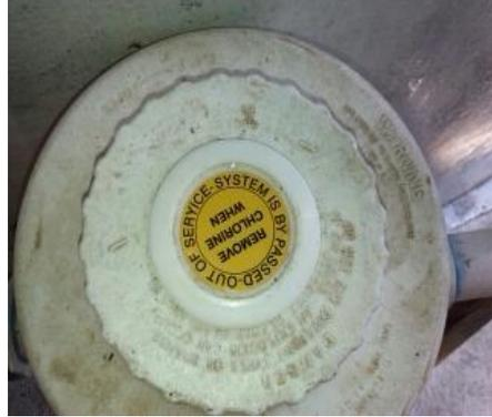
**Fotografía 11 y 12:** Hipo-cloradora HTH de 250gr (Hipoclorito de calcio), instalada en el tanque 2.
