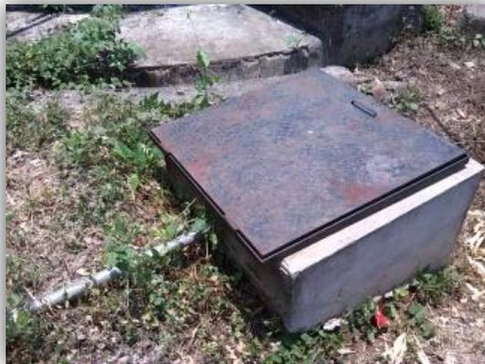
**Fotografía 13:** Válvulas de salida del tanque 2 protegida con una caja de sistema mixto y tapadera metálica.
