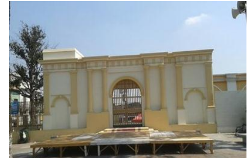
Foto MTC-15, Reconstrucción de la Fachada de La Iglesia San José
