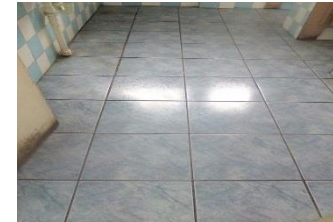
Cerámicas en pisos en espacios de los baños
