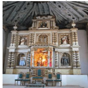
Foto MTC-12, Restauración del Retablo Principal de la Iglesia Santa Cruz de Roma,
