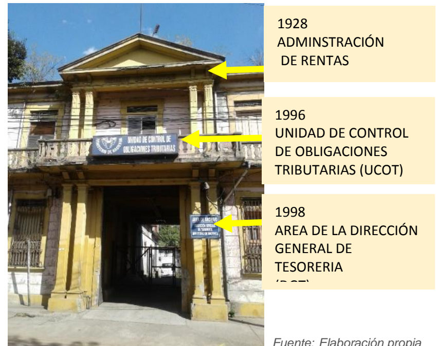
Foto MA-11_Acceso principal del Edificio
