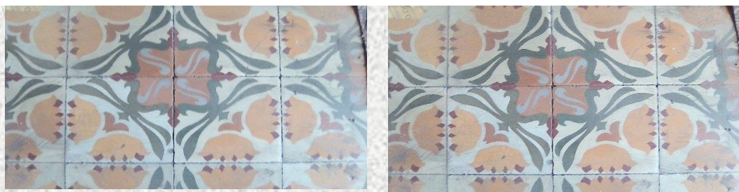
FOTOS MA-19_ PISO TIPO ALFOMBRA EN ESPACIOS DEL SEGUNDO NIVEL
