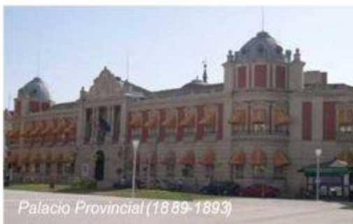
Palacio Provincial (1889-1893) Fuente: Propuesta de Valorización Arquitectónica de Edificaciones del Centro Histórico de Santa Tecla.
