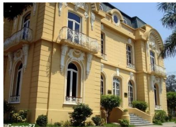
Foto MTC-13 Rehabilitación de la Casa Dueñas.
