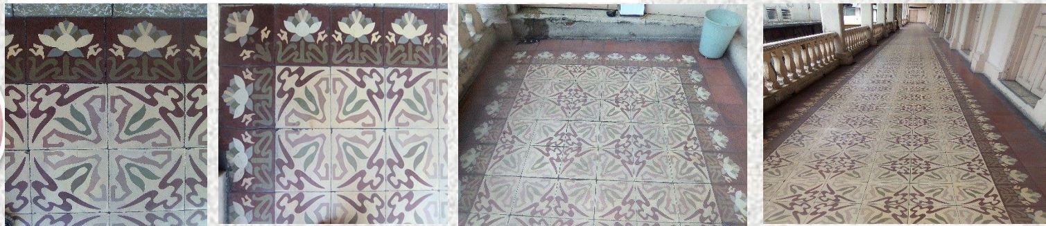
FOTOS MA-17_ PISO TIPO ALFOMBRA EN CORREDORES DEL SEGUNDO
