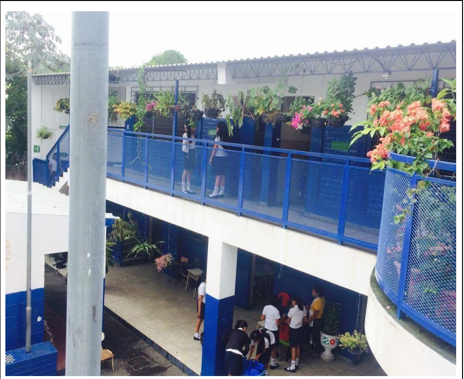
El Centro Escolar posee segunda planta en sus instalaciones.
