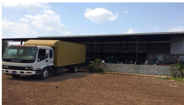
Ilustración 13 Camión listo para ser cargado en la zona de carga
