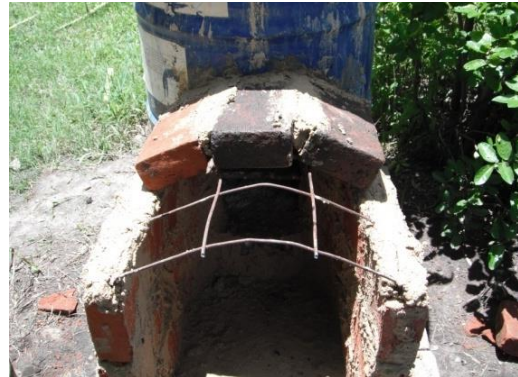
Fig. 72 y 73. Detalle de la primera línea de ladrillos para aumentar la cámara de cocción y la construcción del techo de la cámara de combustión. Fuente: Equipo investigador.
