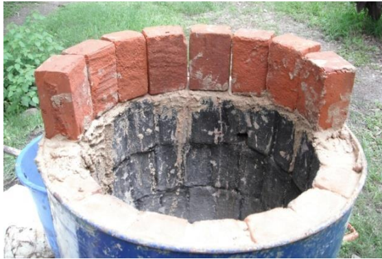
Fig. 72 y 73. Detalle de la primera línea de ladrillos para aumentar la cámara de cocción y la construcción del techo de la cámara de combustión. Fuente: Equipo investigador.
