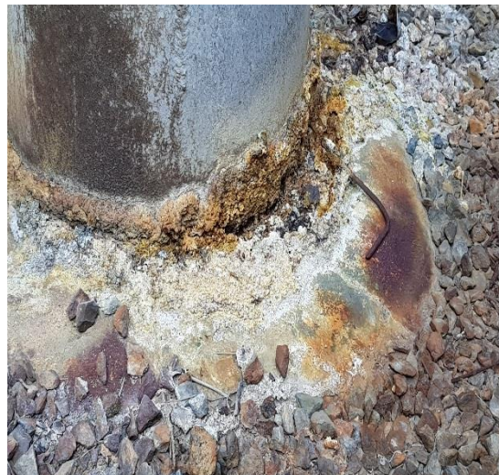
Fotografía 6. Corrosión.
