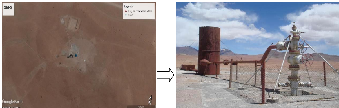
Figura 12: Pozo geotérmico Sol de Mañana 5
