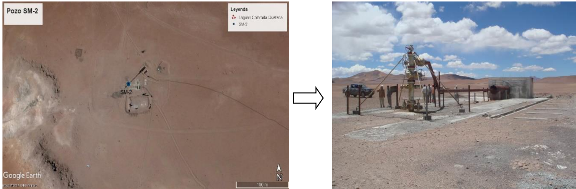
Figura 6: Pozo geotérmico Sol de Mañana 2
