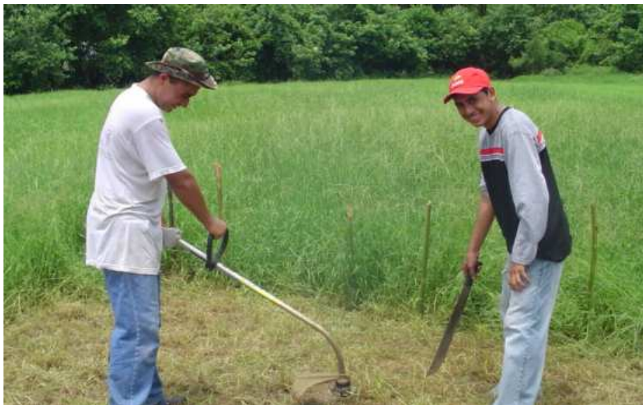
Figura 13. Corte de Uniformizacion del Pastizal, paso 1.
