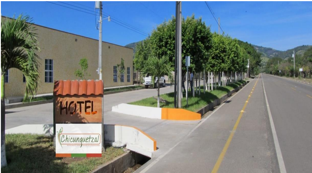
Anexo 6: Fachada de entrada y parqueo
