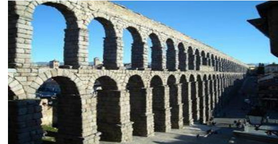
Fuente: internet arquitectura Romana
