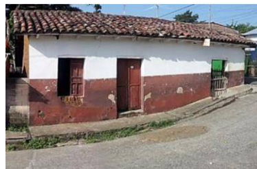
Fotografía 050: Tipo de Arquitectura Colonial. (Vivienda.)
