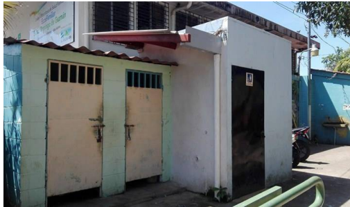
Fotografía 047: Servicios sanitarios públicos frente a mini plaza.
