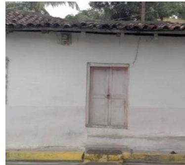
Fotografía 052: Tipo de Arquitectura Colonial. (Vivienda.)
