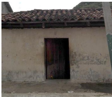
Fotografía 051: Tipo de Arquitectura Colonial. (Vivienda.)
