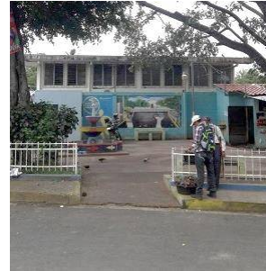
Fotografía 033: Rampas de acceso a mini plaza.
