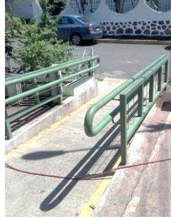
Fotografía 045: Rampa de acceso a mini plaza.
