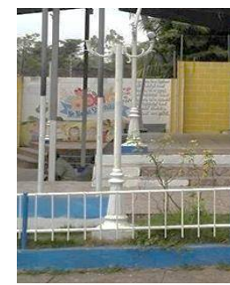
Fotografía 042: Luminarias frente a kiosco (mal estado).
