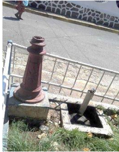
Fotografía 044: Luminaria en mal estado.
