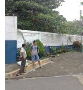
Fotografía 034: Falta de continuidad de la acera peatonal.
