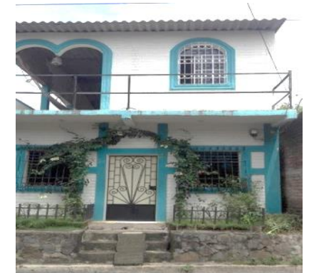
Fotografía 056: Tipo de arquitectura de remesas viviendas a dos niveles, de ladrillo rojo y bloques de concreto, estructuras de acero en techos con cubierta de lámina.
