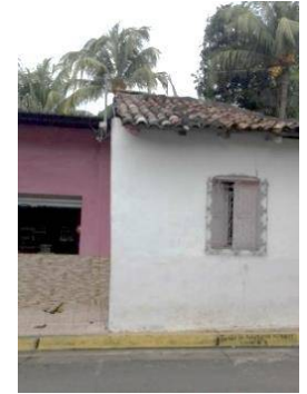
Fotografía 035: Falta de continuidad de la acera peatonal.
