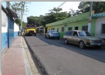
Fotografía 6: Tendido eléctrico y cuneta para el drenaje de aguas lluvias en Avenida Morazán (ciudad de San Pedro Perulapán)
