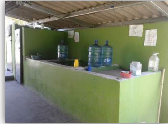
Fotografía 17: Área de aseo existente.
