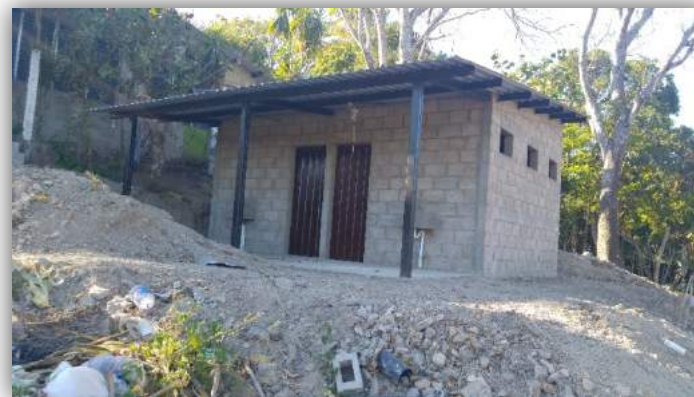
Fotografía 25: Módulo de sanitarios existente
