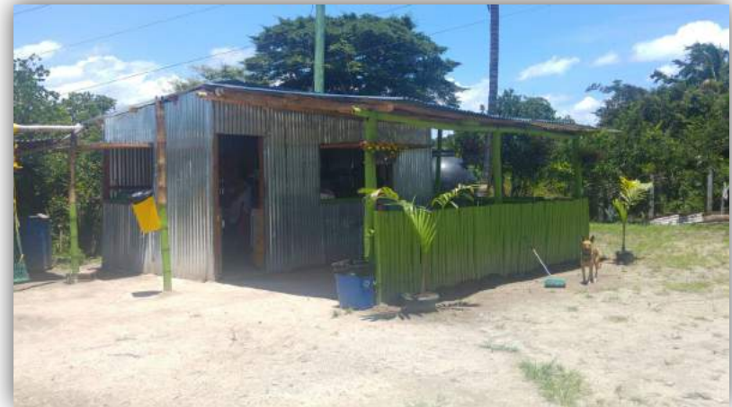
Fotografía 10: Módulo de cafetería (a demoler)
