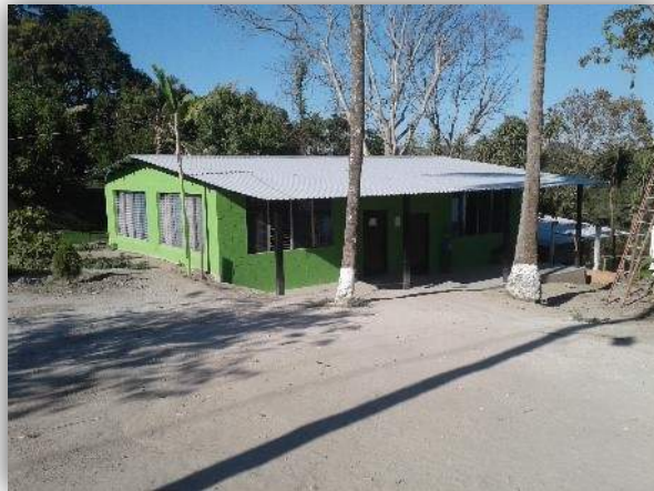
Fotografía 9: Edificio de aulas existentes (a conservar)
