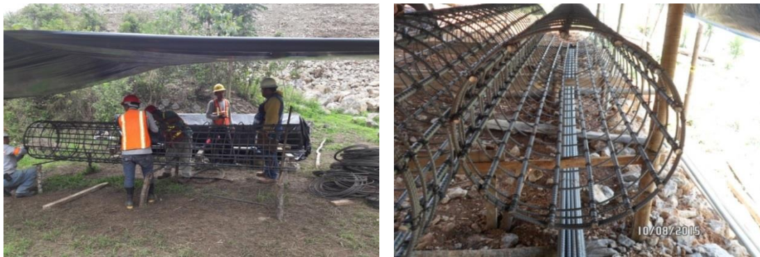
Figura 7.5 Hechura de la armadura de canasta de acero para fundaciones de pata de elefante o acampanada.
