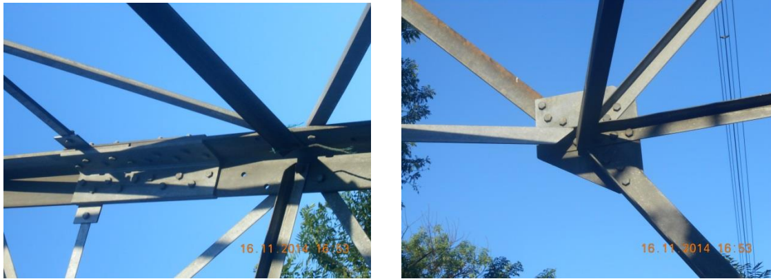
Figura 5.34 Uniones en los perfiles de una torre
