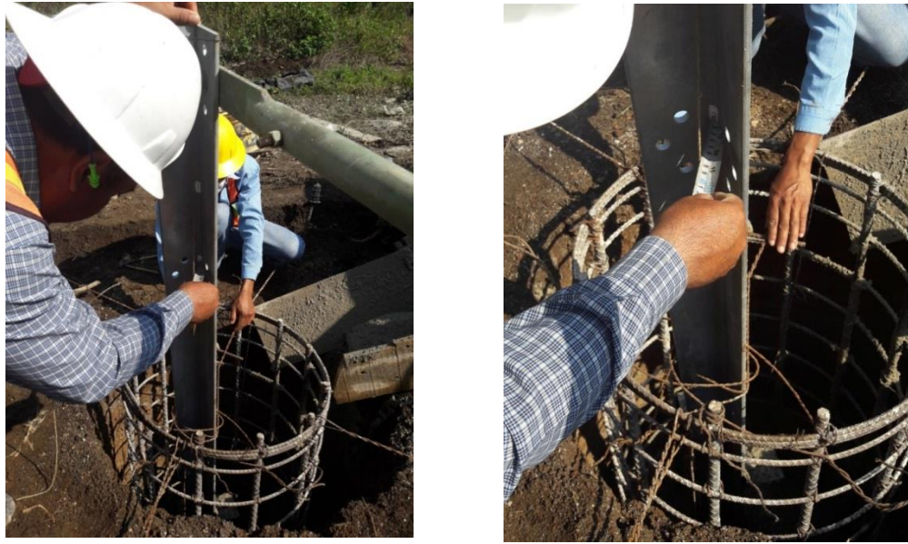
Figura 7.8 Verificación de la pendiente o inclinación tronco piramidal de la estructura.
