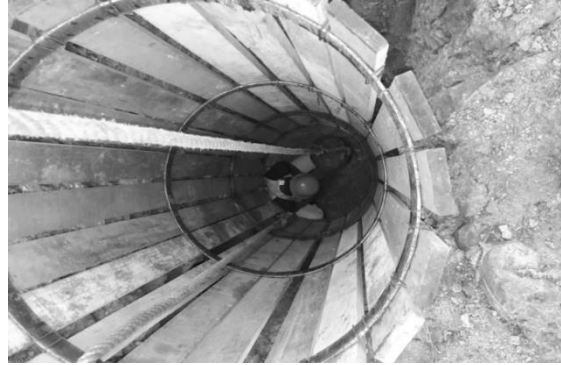
Figura 7.4 Vista en planta de la excavación manual hecha por una persona.
