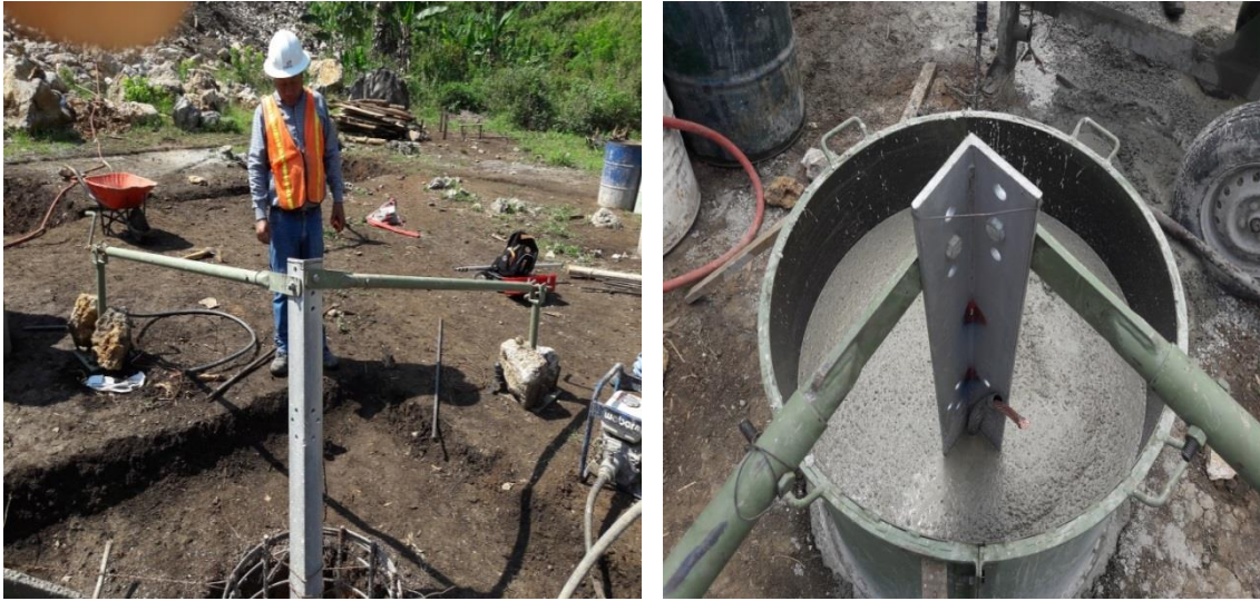
Figura 7.9 (a) vista del Stub con sus respectivos tensores (b) Stub embebido en el concreto del colado.
