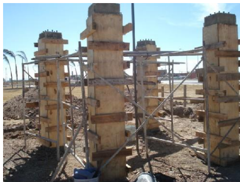
Figura 7.15 Colocación de concreto en los moldes de las patas de la torre
