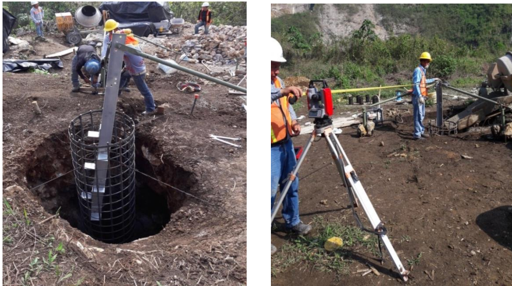
Figura 7.7 Colocación del Stub y verificación de la distancia entre patas.
