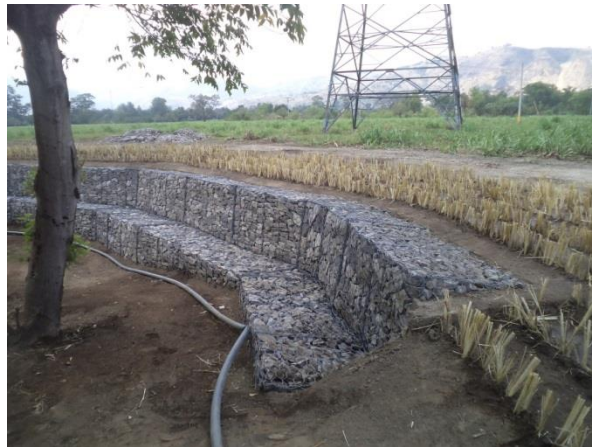
Figura 7.12 Obras de protección para torre de transmisión de alta tensión con gaviones y zacate vetiver.
