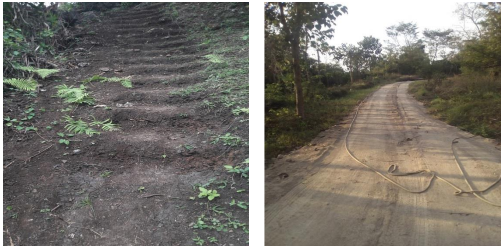
Figura 7.2 (a) Vista de camina de acceso peatonal. (b) Vista de camino de terracería para vehículo.
