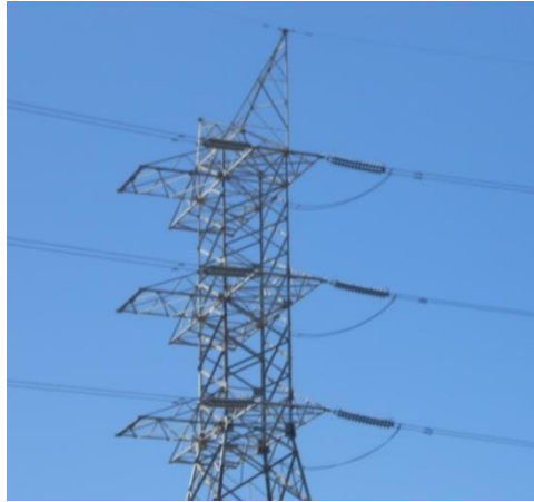
Figura 2.27 Torre especial, torre nº1 en la línea saliendo de la subestación Sonsonate a la subestación de Duke Energy, Acajutla. 28
