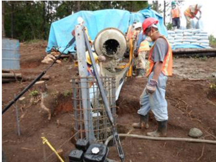
Figura 7.10 Colado de zapata pata de Elefante o Acampanada
