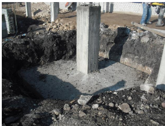
Figura 7.14 Cimentación aislada sin encofrado.
