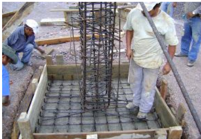
Figura 7.13 Colocación del acero de refuerzo en zapata aislada.
