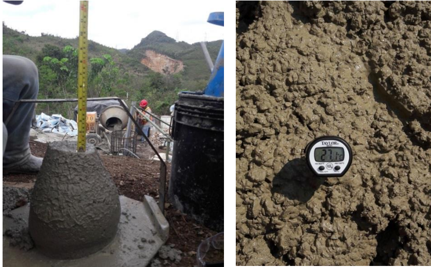
Figura 7.11 Prueba de Revenimiento y temperatura del concreto.
