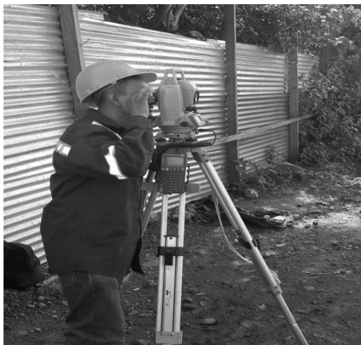
Figura 7.1 Equipo adecuado para el replanteo topográfico (Estación total de doble rebote)
